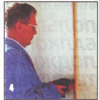
К стене помещения на дюбелях и шурупах крепят вертикальные бруски, располагая их с нужным шагом и выверяя по уровню.
