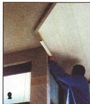
Обшивку по периметру укрывают декоративными планками, соединяя их между собой «на ус».
