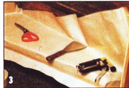
По шаблонам из плотной упаковочной бумаги с высокой точностью выкраивают элементы покрытия.
