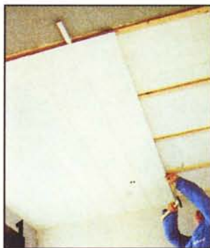
Панели обшивки потолка скрыто крепят к рейкам обрешётки на специальных кляммерах.
