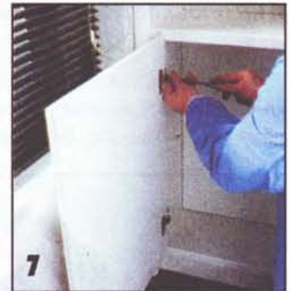
Теперь можно навесить дверки. Внизу видна конструкционная полка с цоколем.
