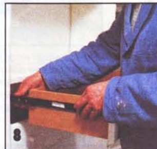
В прикреплённые к несущим стенкам направляющие вставляют выдвижные ящики.
