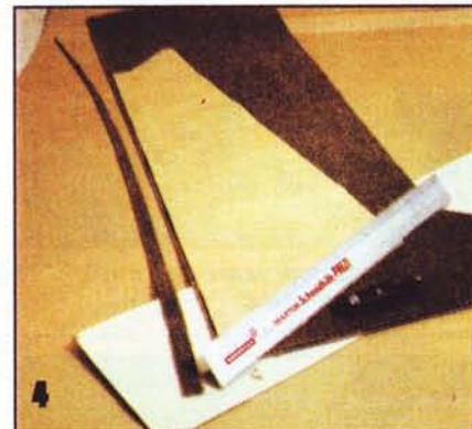
Шаблон и ковролин можно прорезать в один приём, ведя нож по оставленным шпателем на бумаге линиям сгиба.
