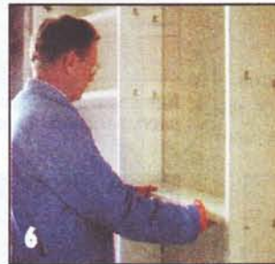
Между несущими стенками крепят полки, придающие конструкции жёсткость. Таким же способом монтируют остальные несущие стенки и полки.
