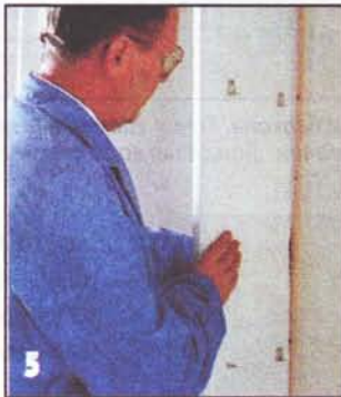
Надвинутые на вертикальные бруски две несущие стенки тщательно выставляют.
